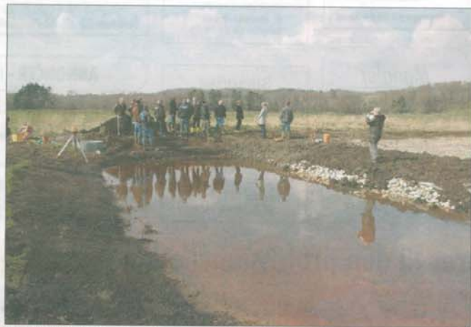
VANDRENSNING: Mini-vådområdet er på størrelse med en tennisbane, hvor midterområdet som vandet skal sive igennem består af en blanding af sten, ral og halm. (Foto: John Ankersen)
