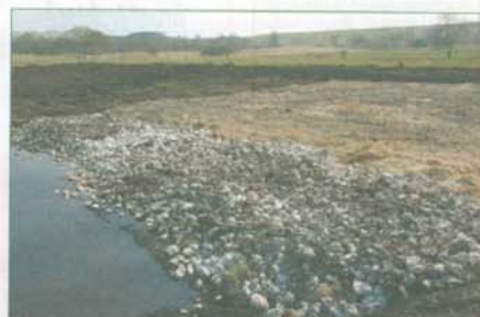
INDLØB: Et indløbsbassin leder vandet ind i gennem blandingsområdet. (Foto: John Ankersen)
